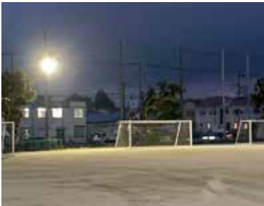
グラウンドを照らす投光器
