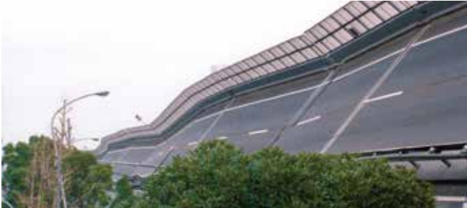
阪神高速倒壊現場（平成 7 年 1 月 18 日）
